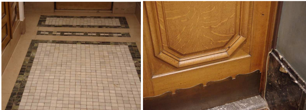
Details van de toegangsgang naar de voormalige kantoren van de Papeteries. © CHE april 2021.
