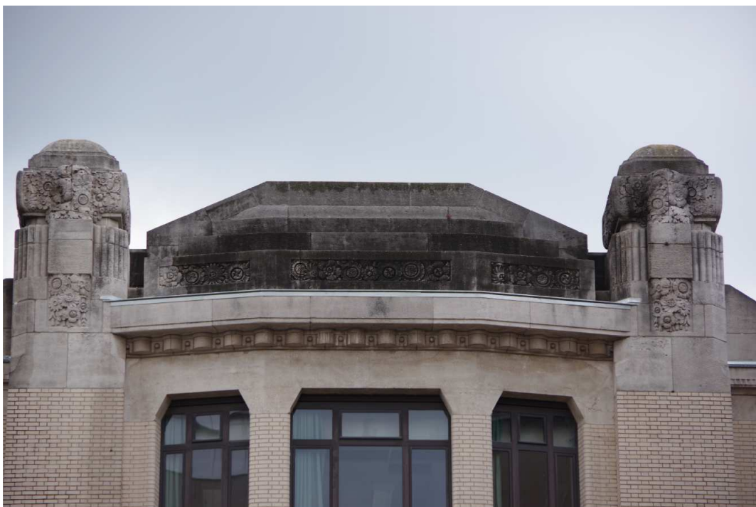
Detail van het fronton en de beeldhouwde sluitstukken in blauwe steen in de top van de gevel © CHE 2021.
