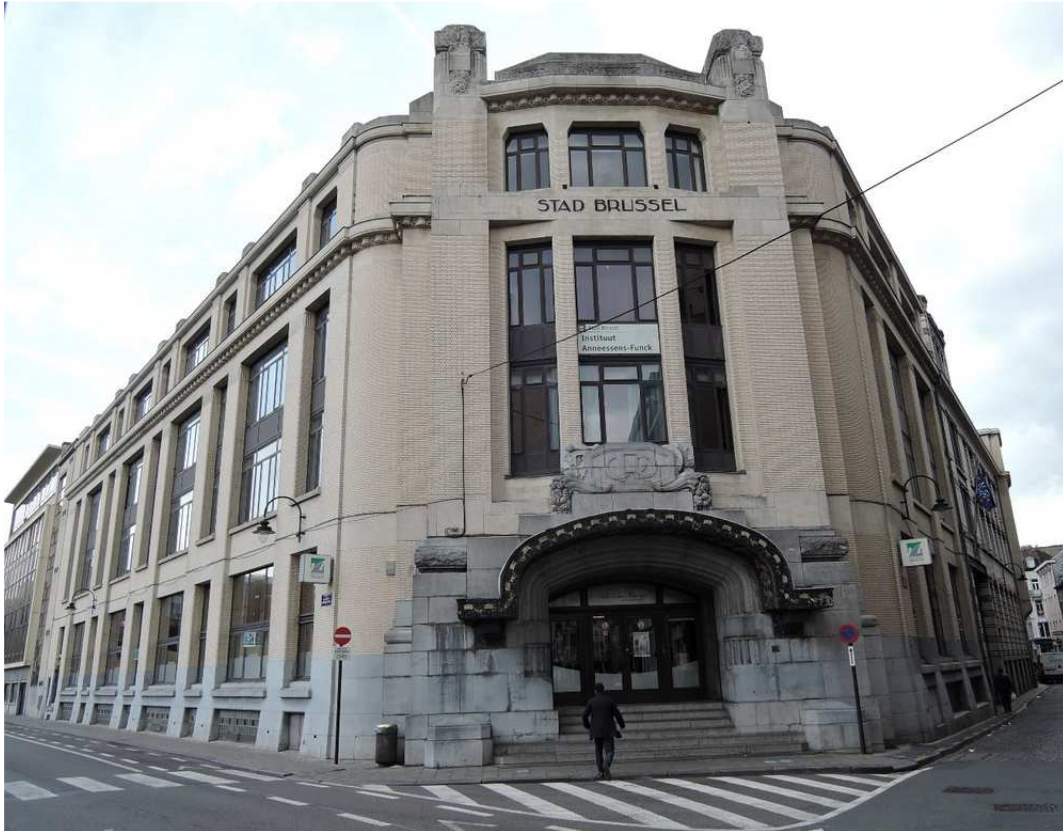
Zicht op de uitbreiding in art-decostijl van Eugène Dhuicque, ontworpen voor de Papeteries De Ruyscher, tussen 1924 en 1927, op de hoek van Groot Eiland en de Zespenningenstraat © monument.heritage 2015.
