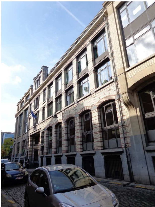
Façade à rue du bâtiment éclectique érigé en 1905 par Ernest Acker pour le compte des Papeteries De Ruysscher © CPH avril 2021.
