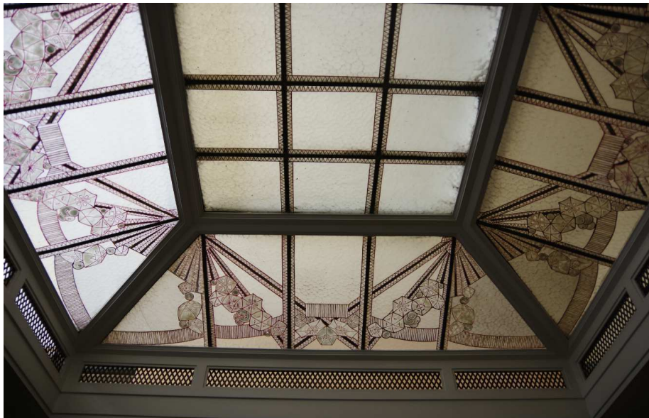
Dakraam van de directietoiletten © CPH april 2021.
