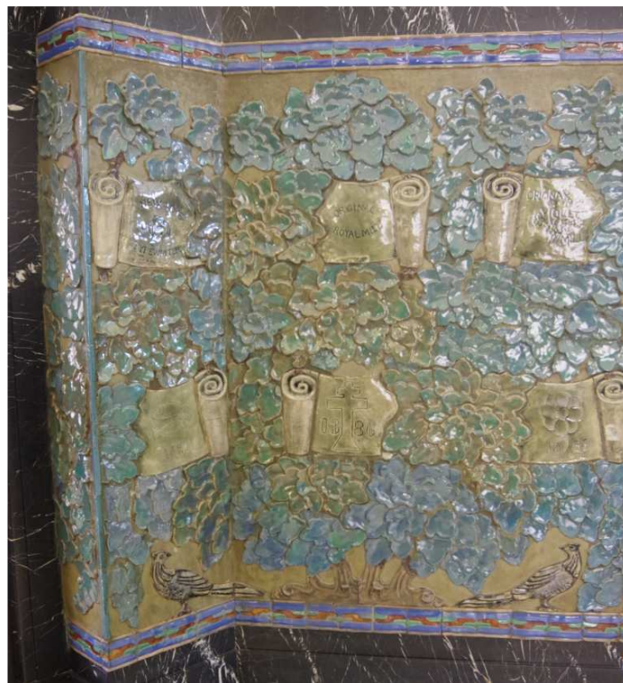
Détail de lambris du hall d'accueil © CPH avril 2021.
